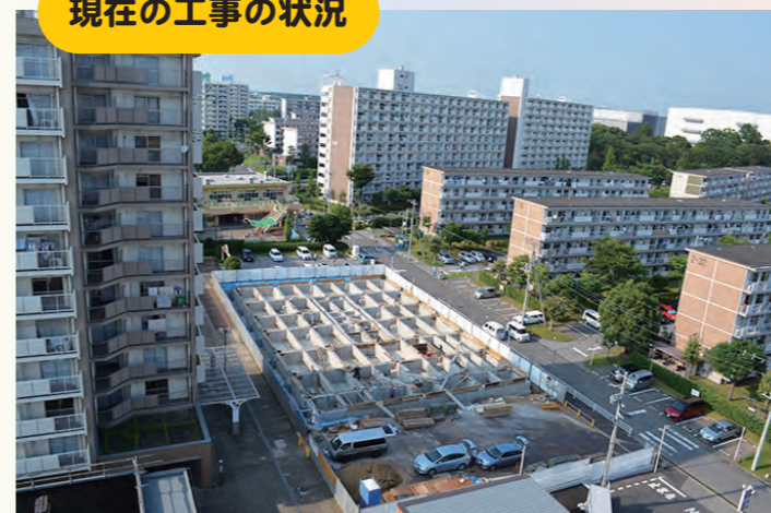
6月末現在、基礎工事のコンクリート打設を行っています。
